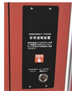
非常通報装置
