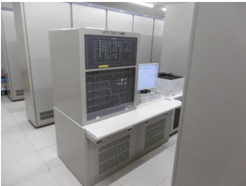
【信号保安設備更新】
