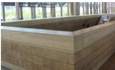
【手すり設置前】
