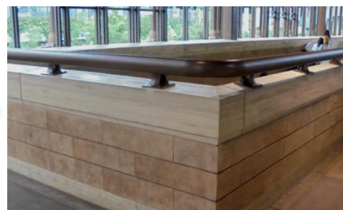
【手すり設置後】
